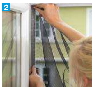
2 Fliegengitter auf das Klettband drücken
