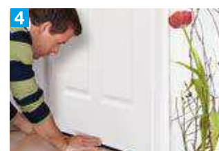
4 Türdichtschiene an der Tür fixieren
