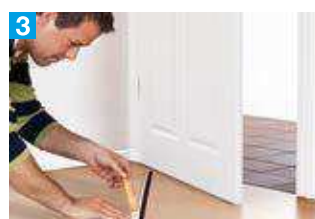
3 Klebestreifen abziehen
