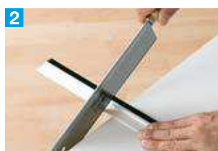
2 Türdichtschiene auf Maß zusägen
