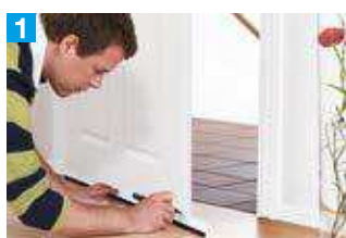
1 Türbreite auf Türdichtschiene übertragen
