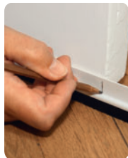
Türbreite auf Türdichtung übertragen
