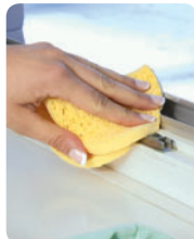
Verklebungsfläche gründlich reinigen
