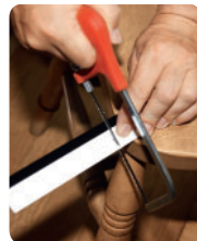
Türdichtung auf Maß zusägen
